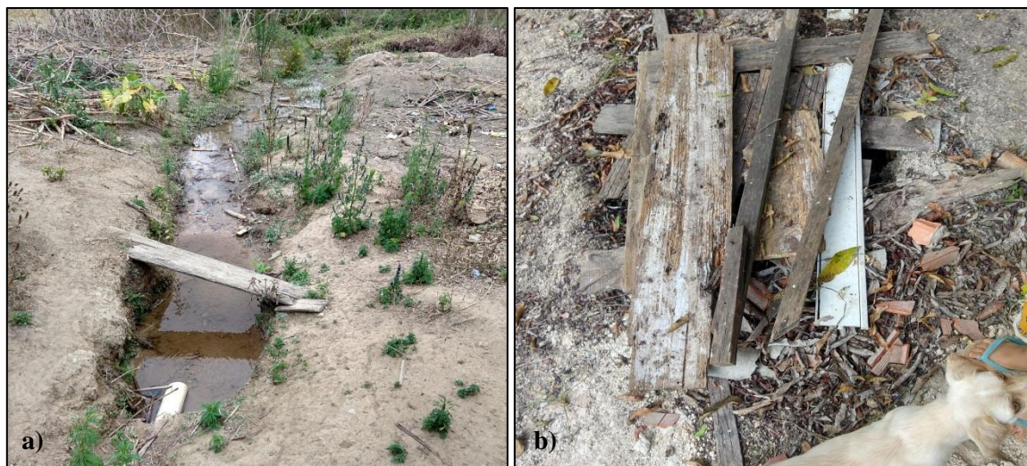
Figura 2 – a) Esgoto a céu aberto; b) Fossa negra
